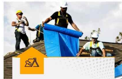
Roof Tarp/Shrink Wrapping
