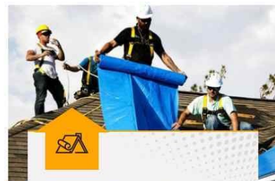
Roof Tarp/Shrink Wrapping
